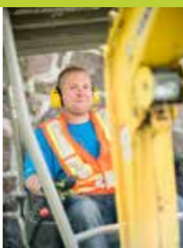
Réalisation d'aménagements paysagers (DEP)
